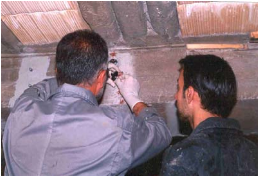
شکل ۱۱- نصب روزنه های سطحی تزریق
