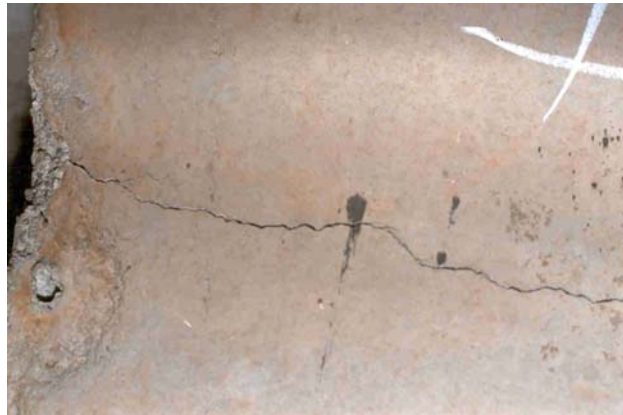
شکل ۷ - نمونه ای ترکهای مشاهده شده در یک تیر
