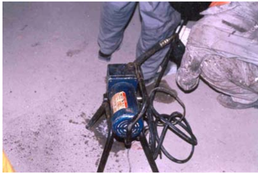
شکل ۱۳- پمپ ویژه تزریق ترک
