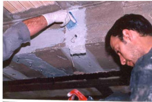
شکل ۱۲- درزگیری سطح ترک با رزین اپوکسی ویژه
