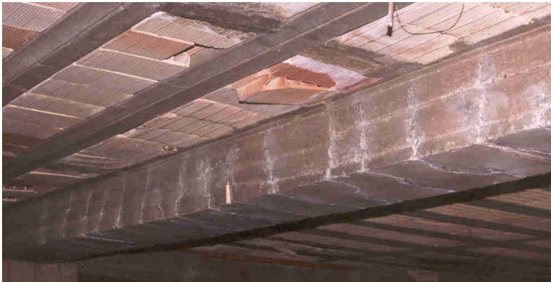
شکل ۶ - نمونه ای ترکهای مشاهده شده در یک تیر
