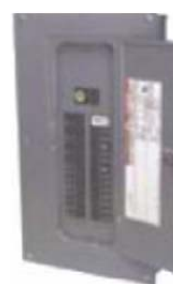
شکل ۱-۱۰۴- مرکز بار (نصب شده داخل دیوار)
