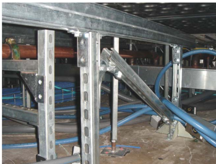
شکل ۵-۲۶- قاب بندی فولادی برای مهار کف کاذب
