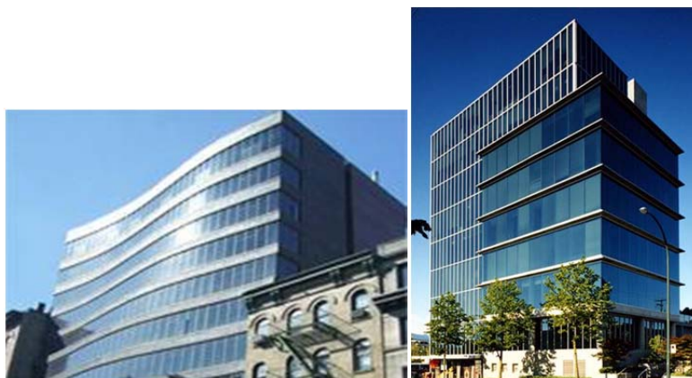
شکل ۱-۷- نمای شیشه‌ای بیرونی بین کف‌های طبقات
