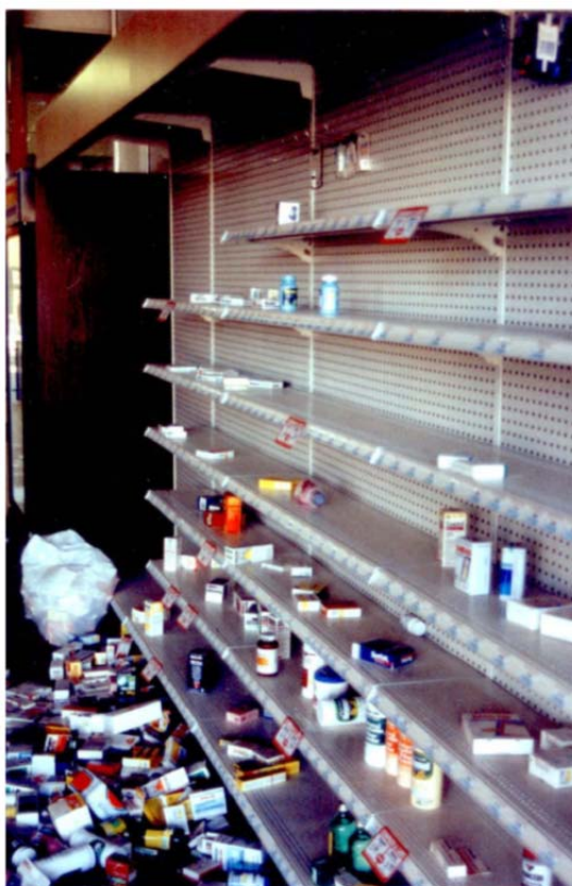
شکل پ ۲-۲۵- افتادن داروها از قفسه‌های نگهداری آن در زلزله ۱۹۹۴ نورث ریج
