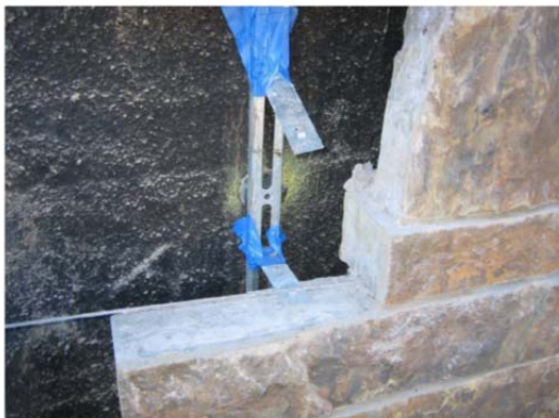
شکل ۳-۵- نصب نمای سنگی
