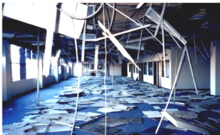
شکل پ ۲-۴- خرابی و فروریزش سقف کاذب و چراغ‌های سقفی در زلزله ۱۹۹۴ نورث ریج
