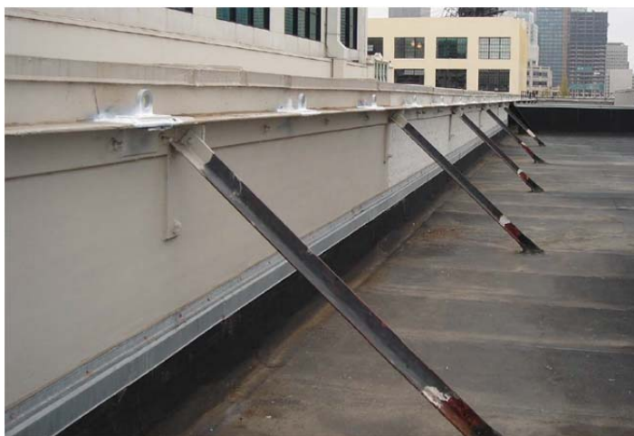
شکل ۵-۱۹- نمونه‌ای از نحوه مهار جان‌پناه غیر مسلح بنائی
