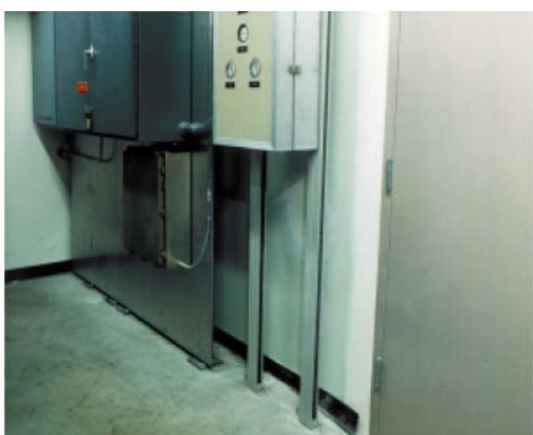
شکل ۵-۱۵۱- دو روش مختلف برای نگهداری کنترل پانل: با استفاده از یک صفحه فولادی متصل به کف و سقف با استفاده از قلاب‌های فولادی (چپ)؛ با استفاده از پایه‌های امتداد یافته تا کف و سقف (راست)
