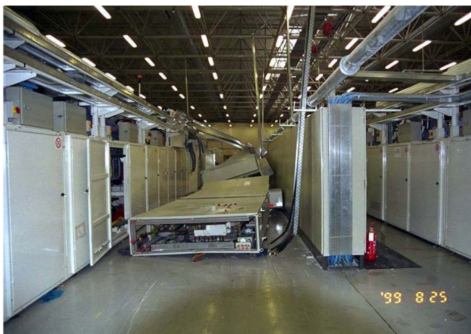
شکل پ ۲-۲۲- واژگونی کابین‌های الکتریکی مهار نشده در کارخانه تولید کاغذ در زلزله ۱۹۹۹ ازمیت ترکیه با بزرگای ۷/۴
