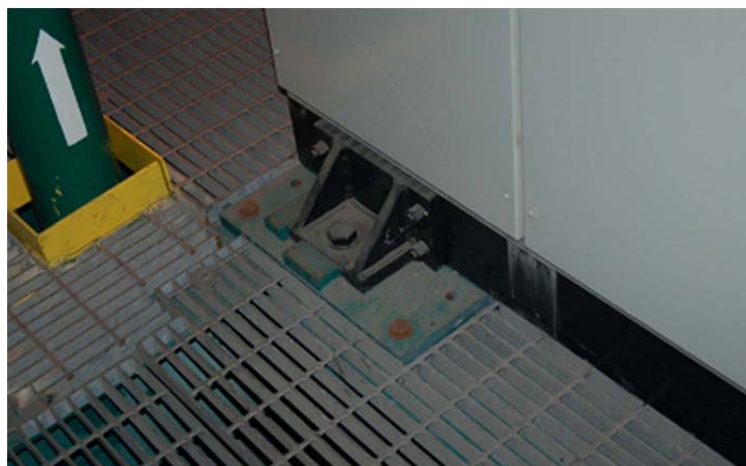
شکل ۵-۳۷- نمونه اجرا شده اتصال جزء غیر سازه‌ای به وسیله نبشی
