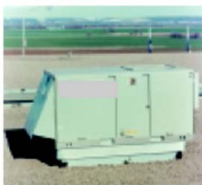
شکل ۱-۳۰- واحد هواساز کوچک قرار گرفته بر روی بام
