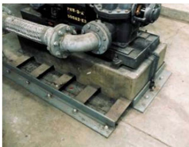
شکل ۴۲-۵- نمونه اجرا شده ضربه‌گیر در نزدیکی درز بتنی
