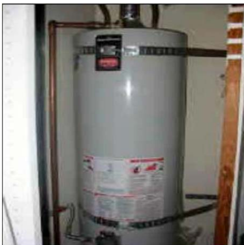
شکل ۵-۴۷- اتصال اعضای استوانه‌ای به کمک تسمه کششی
