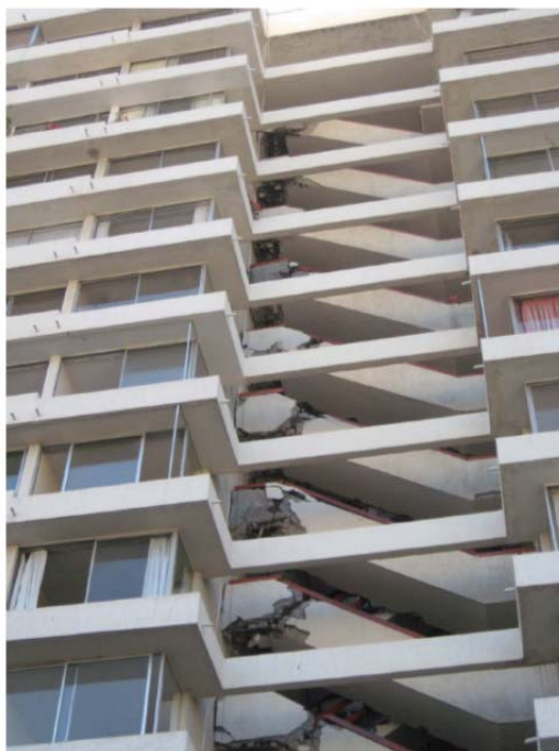
شکل پ ۲-۱۰- خرابی راه‌پله تمام طبقات ساختمان در Vina del mar در زلزله ۲۰۱۰ شیلی به بزرگا ۸.۸ راه‌پله‌ها به صورت صلب به طبقات متصل شده بودند و به صورت بادبند قطری عمل کرده‌اند در حالی که برای این طراحی نشده‌اند.
