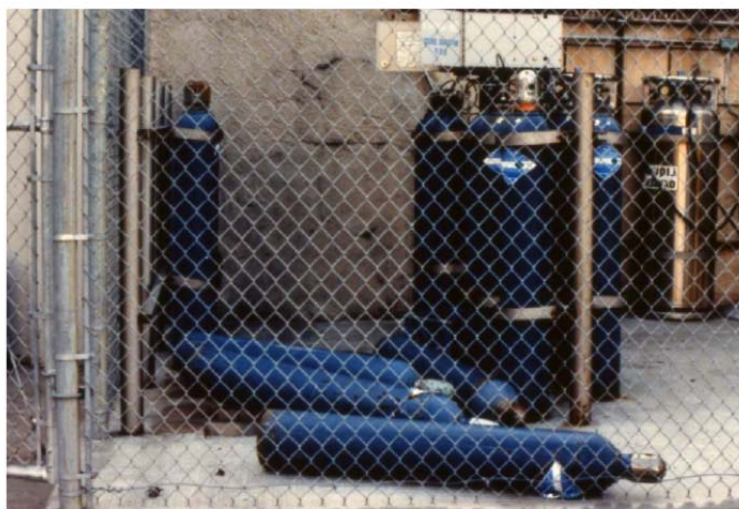
شکل پ ۲-۱۷- افتادن و خطر انفجار سیلندرهای اکسیژن مهار نشده در زلزله نورث ریج ۱۹۹۴
