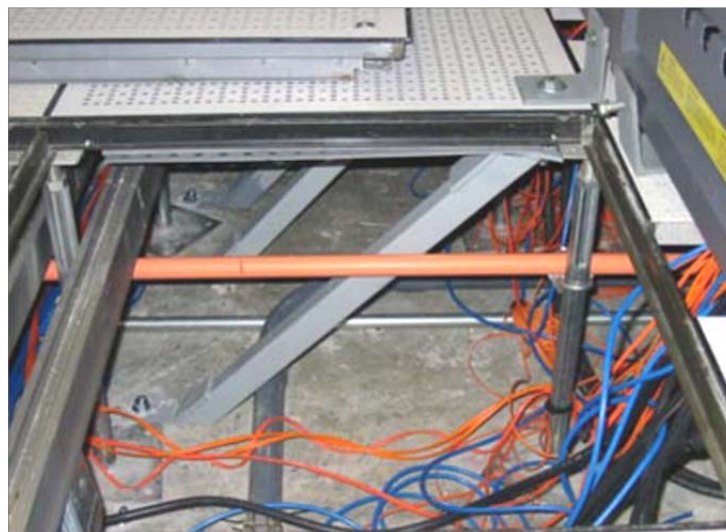
شکل ۵-۲۵- نمونه‌ای از نحوه مهار اجزای کف کاذب
