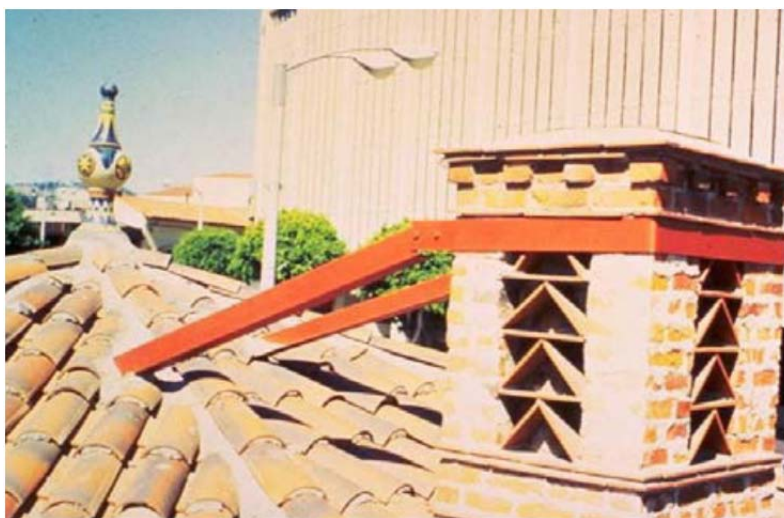
شکل ۵-۲۲- نمونه‌ای از نحوه مهار دودکش
