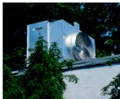
شکل ۱-۵۴- کولر با مخزن آب همراه
