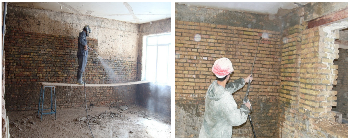
شکل ۸: نمایی از اجرای صحیح برداشت نازک کاری
