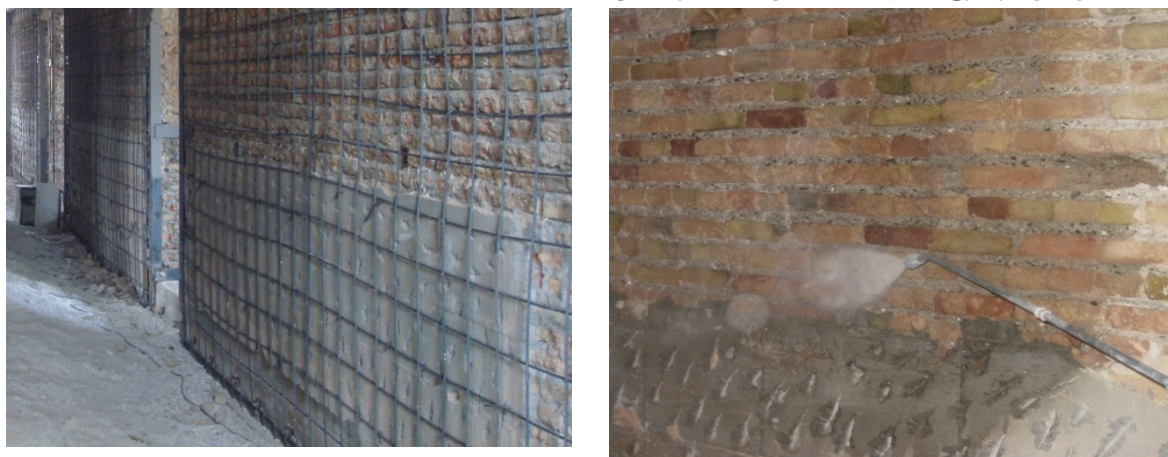
شکل ۹: نمایی از مضرس نمودن دیوارهای با پوشش سیمانی
