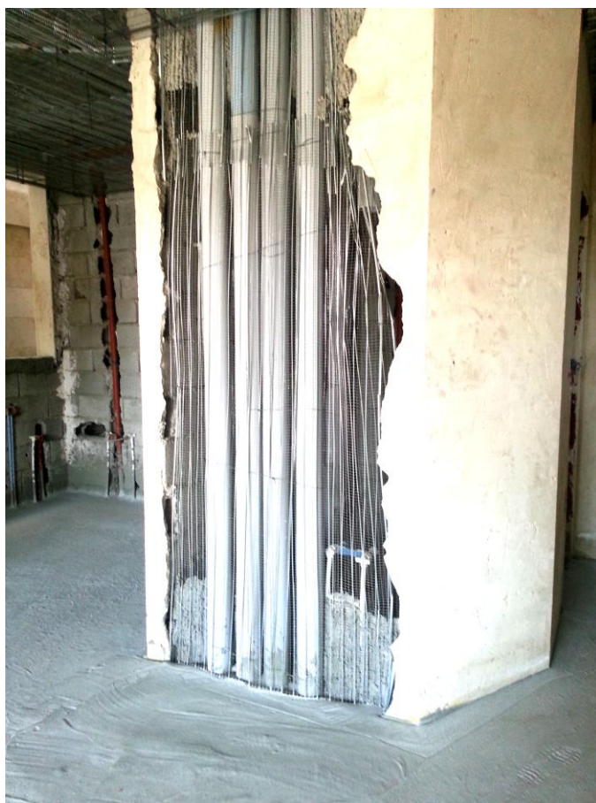
شکل ۱۱- تخریب دیوارها جهت عبور لوله های تاسیساتی
