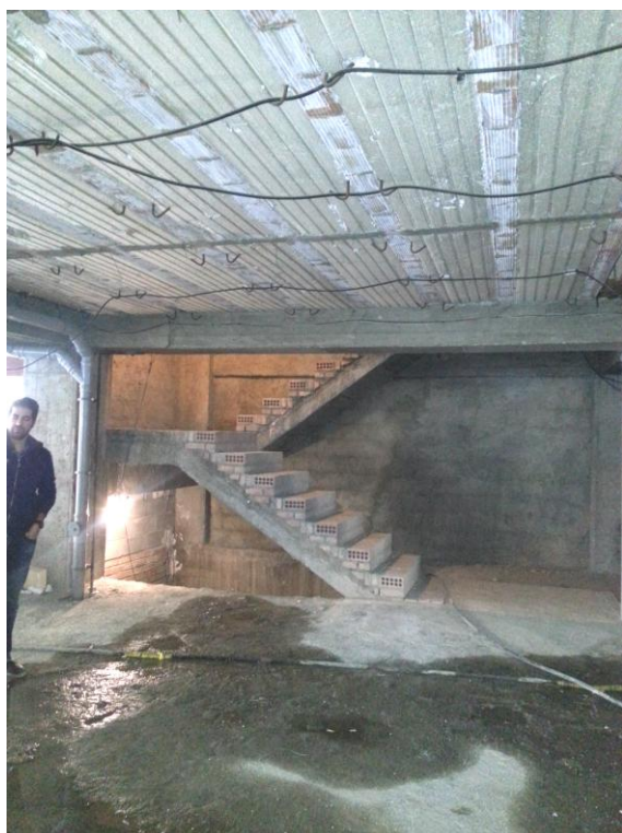
شکل ۱۴- عدم وجود نرده موقت و پاخور در اطراف پرتگاه راه پله
