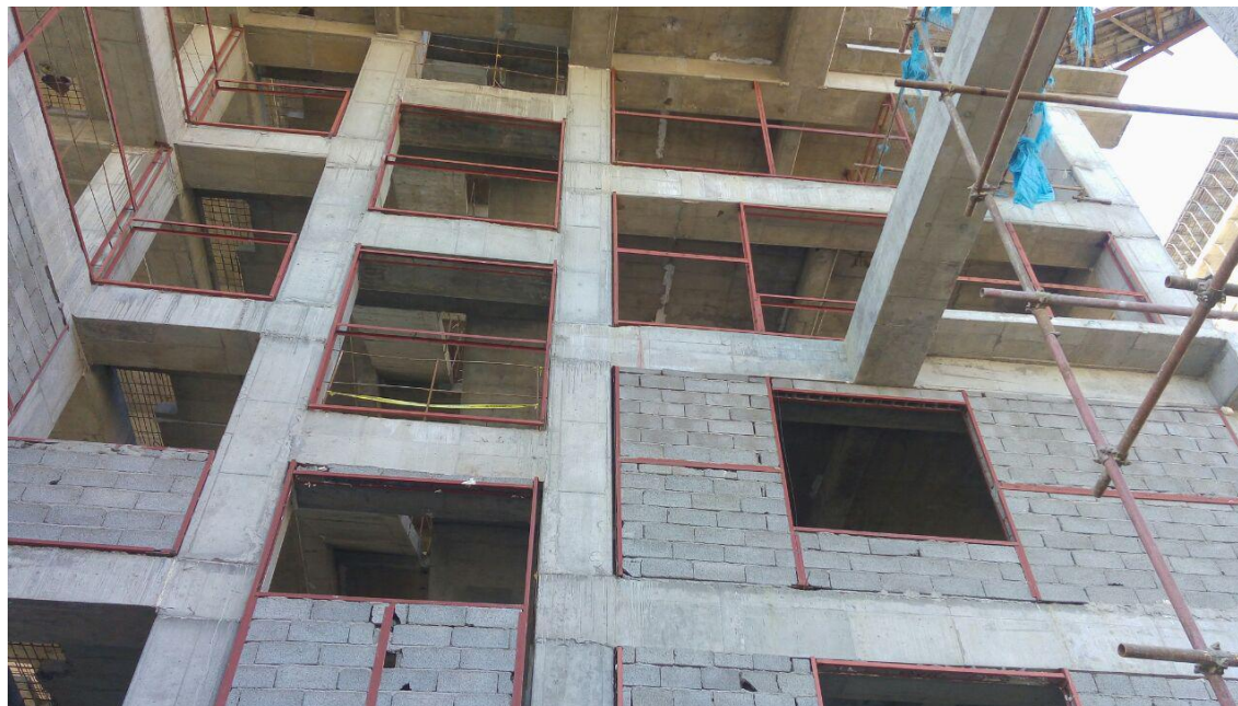
شکل ۴- اجرای وال پست ها جهت اجرای دیوارهای پیرامونی در قاب خمشی مطابق با نقشه های مصوب.
