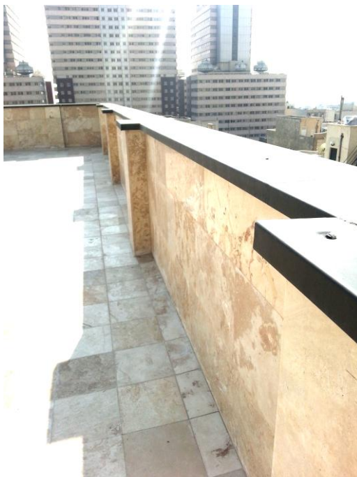
شکل ۱۲- سمت راست: اجرای صحیح پشت بندی ها و درپوش جانپناه بام مطابق با نقشه های مصوب. سمت چپ: عدم اجرای پشت بند و درپوش جانپناه بام
