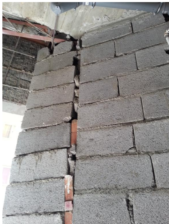
شکل ۶- عدم اتصال صحیح بین دو دیوار غیر سازه ای.
