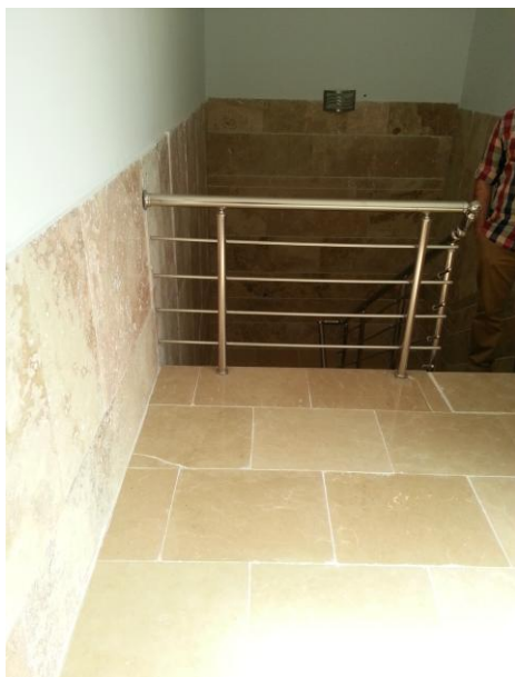
شکل ۲۰- استاندارد نبودن ارتفاع نرده دست انداز پله (کمتر از ۰/۹ متر است) و فاصله قیدها بصورت افقی و بیشتر از ۰/۱۱ متر می باشد.
