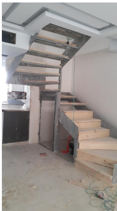
شکل ۱۷- کنترل نازککاری در پلکان داخلی و خارجی و مضرس بودن سطح کف در مسیر های خروج
