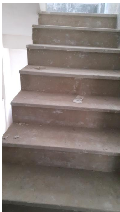
شکل ۱۷- کنترل نازککاری در پلکان داخلی و خارجی و مضرس بودن سطح کف در مسیر های خروج
