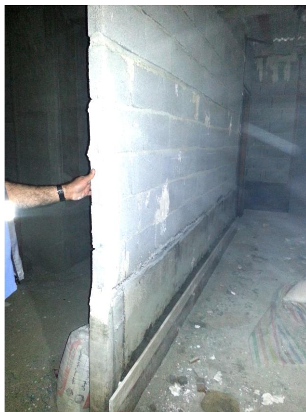
شکل ۵- کنترل ضخامت دیوارهای خارجی و مجاور فضاهای کنترل نشده
