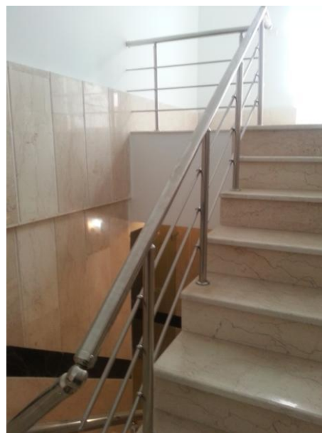
شکل ۲۰- استاندارد نبودن ارتفاع نرده دست انداز پله (کمتر از ۰/۹ متر است) و فاصله قیدها بصورت افقی و بیشتر از ۰/۱۱ متر می باشد.
