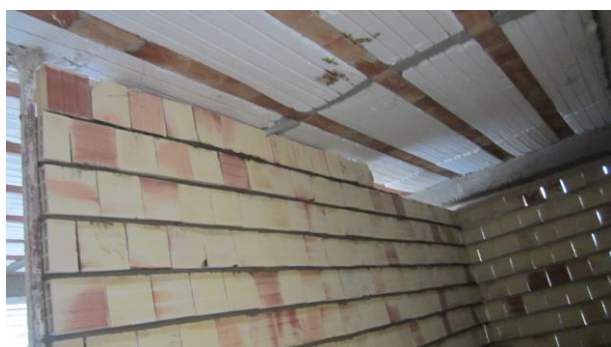
شکل ۷- عدم تراشیدن بلوک پلی استایرن ( به جهت امتداد دیوار بین واحدهای مستقل تا زیر بتن سقف).
