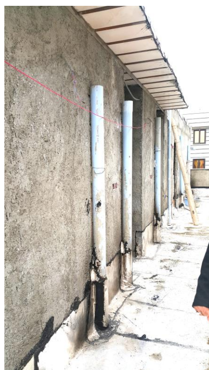
شکل ۱۳- عدم محافظت اطراف لوله های ونت
