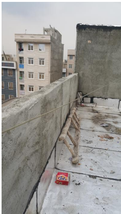
شکل ۱۲- سمت راست: اجرای صحیح پشت بندی ها و درپوش جانپناه بام مطابق با نقشه های مصوب. سمت چپ: عدم اجرای پشت بند و درپوش جانپناه بام
